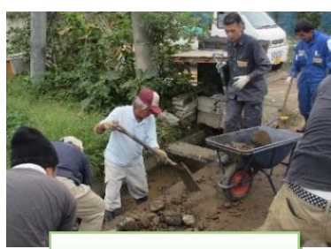
泥の掻き出し
